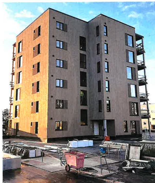
Bilde; Byggeplass - Tinnheitoppen, byggetrinn 1.
